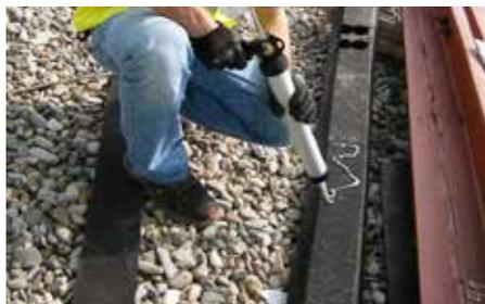
Applicare in maniera uniforme la colla sulla superficie del primo elemento di profilo
