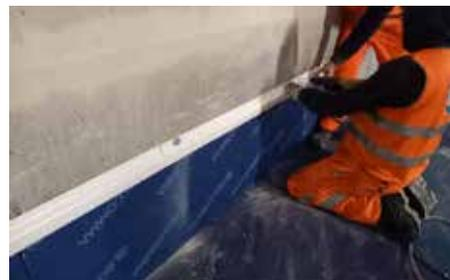
Fissare i pannelli laterali tramite colla o profilo in plastica sagomato
