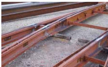
Sollevare da terra il telaio delle rotaie ed eliminare elementi estranei dalle superfici laterali
