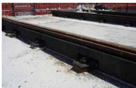
Installazione del profilo della rotaia e del rivestimento sotto la rotaia (soluzione PROTRACK)
