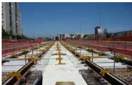
Fase di livellamento e allineamento dei binari, mediante cavallotti che regolano l'altezza del dispositivo - rotaie
