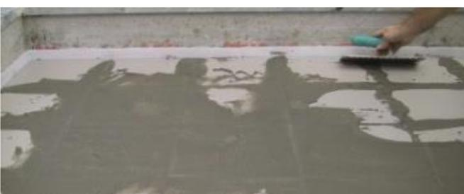
**6** Ad inizio indurimento della fuga, pulire la superficie delle piastrelle
