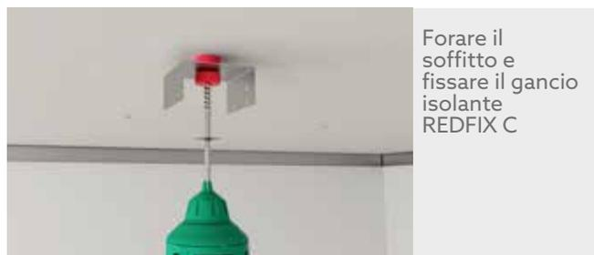
Forare il soffitto e fissare il gancio isolante REDFIX C
