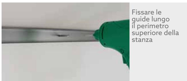
Fissare le guide lungo il perimetro superiore della stanza
