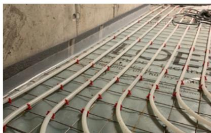
Nel caso di riscaldamento a pavimento posare la rete e il pannello radiante sopra al materassino
