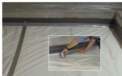
Applicare uno telo protettivo prima della realizzazione del massetto. Coprire con precisione e sigillare il telo ai bordi e nelle giunzioni con nastro Stik
