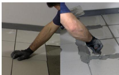
Stendere lo strato di colla e posare le piastrelle. In seguito eseguire la fugatura e pulire la superficie delle piastrelle
