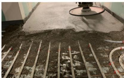
Gettare il massetto in sabbia e cemento o autolivellante. Attendere i tempi di asciugatura
