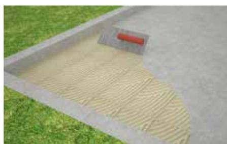
Applicare l'apposito collante sulla superficie in cemento, con spatola dentata da 3 mm
