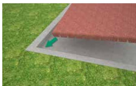
Avviare l'installazione da un angolo della superficie da ricoprire lasciando a vista il lato predisposto per i connettori
