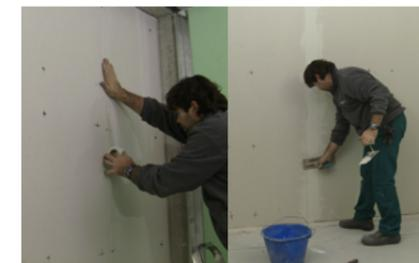
Applicare il nastro in rete nelle giunzioni delle lastre. Stuccare le giunzioni
